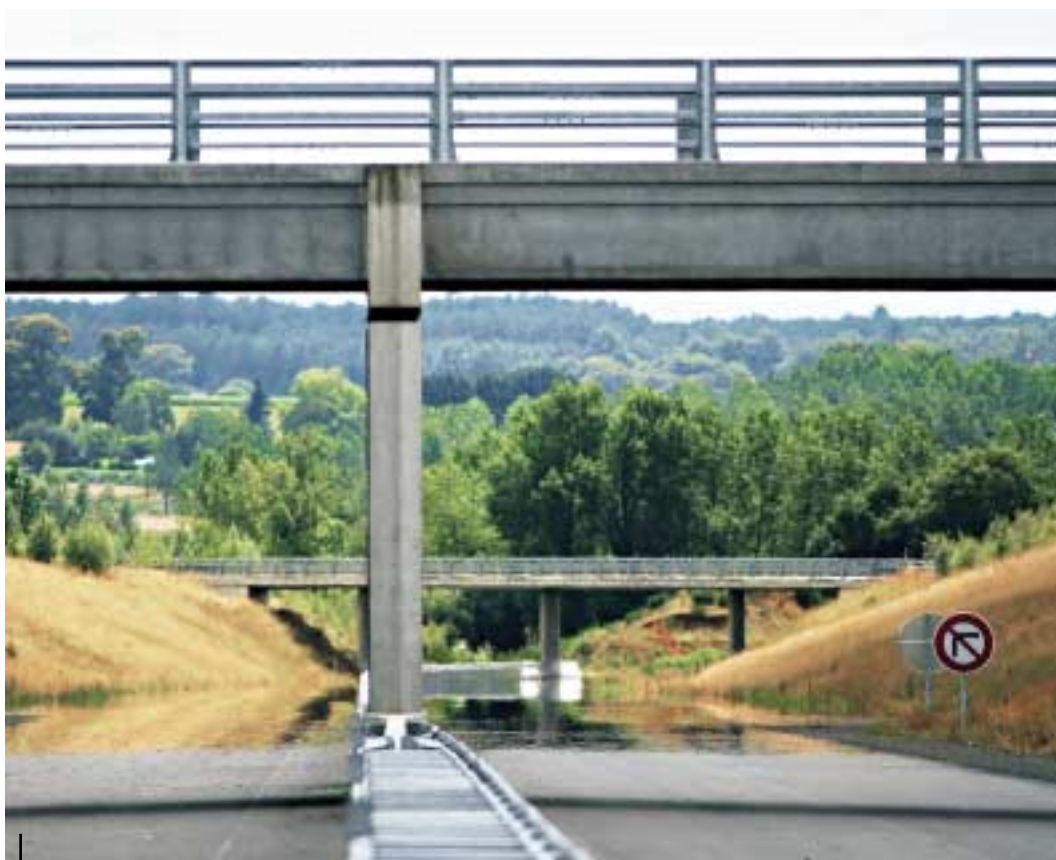
Les travaux à hauteur d'Ecommoy vont bientôt permettre d'achever le dernier tronçon de l'A28 en Sarthe
